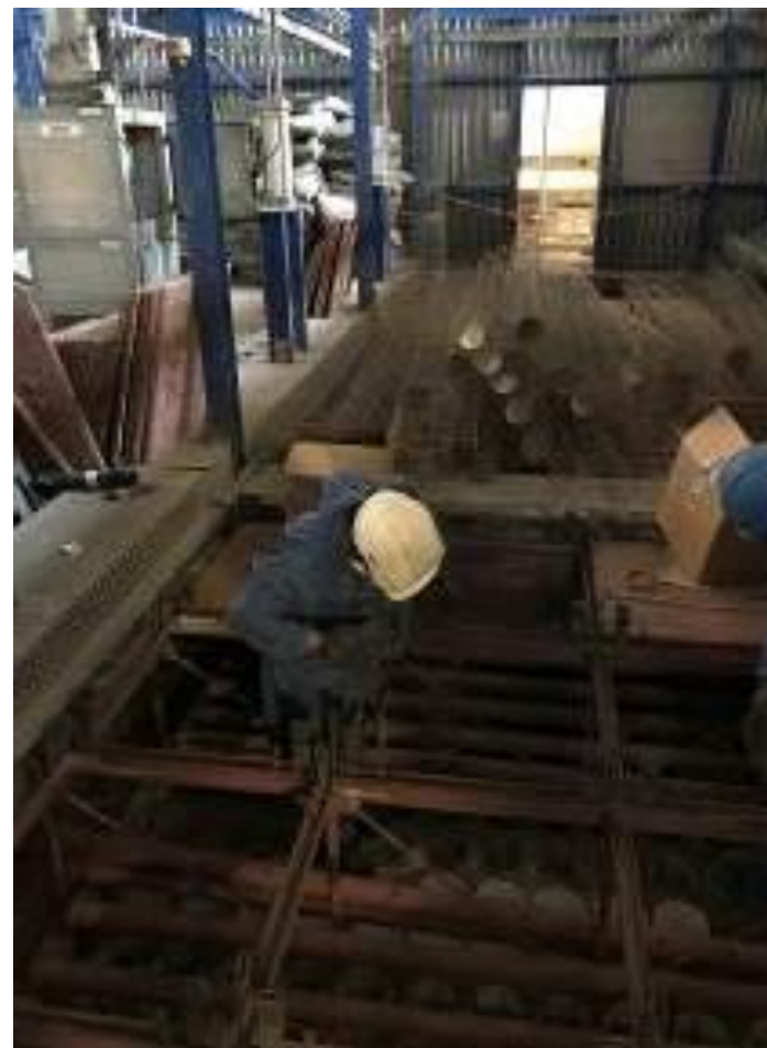
Contrôles et travaux de nettoyage sur les filtres à manches
